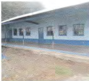
Foto 3: Sustrucción de ventanmas de madera por pvc con vidrio, en Módulo 1
