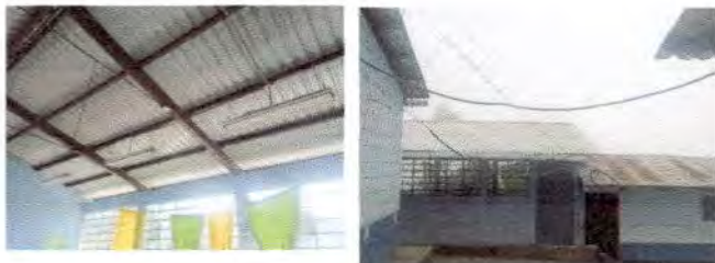
Foto7: Sustitución de lámparas tipo led, reparación de cableado eléctrico, en Módulo 1 y 2
