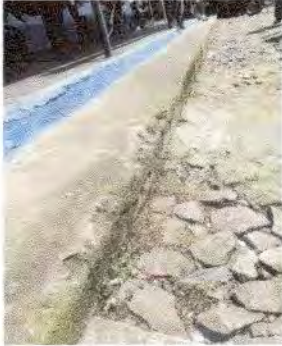
Foto 1: Sustrucción de piso de torta de cemento por piso altideslizante, en Módulo 1 y Dirección
