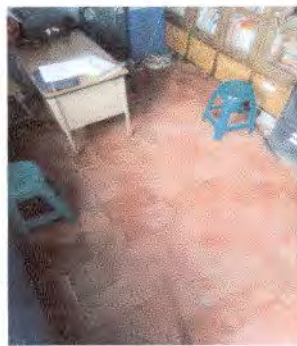
Foto 1: Sustrucción de piso de torta de cemento por piso altideslizante, en Módulo 1 y Dirección
